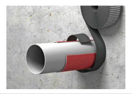
Die lange Nase des Hakens in die lange Nase des Bands einführen und durch Herunterdrücken des Hakens und abschließendes Umbiegen der Nase um 90° die jeweiligen Befestigungspunkte festlegen
