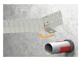
Die Haken an den entsprechenden Positionen einhängen, die um 90° umgebogene Lasche durch die Öffnung führen und zurückbiegen, so dass der Haken fest sitzt.
